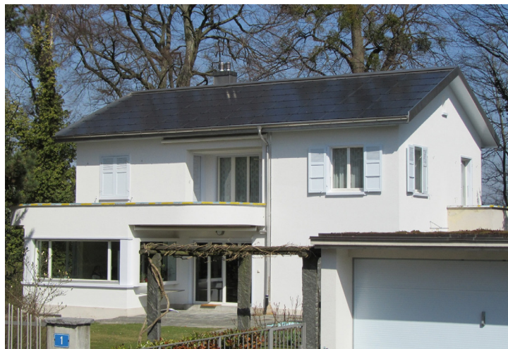
Vollständig integriertes PV-Dach an der Eichhornstraße in Basel. Baujahr 2012. Quelle: Luka Takoa
