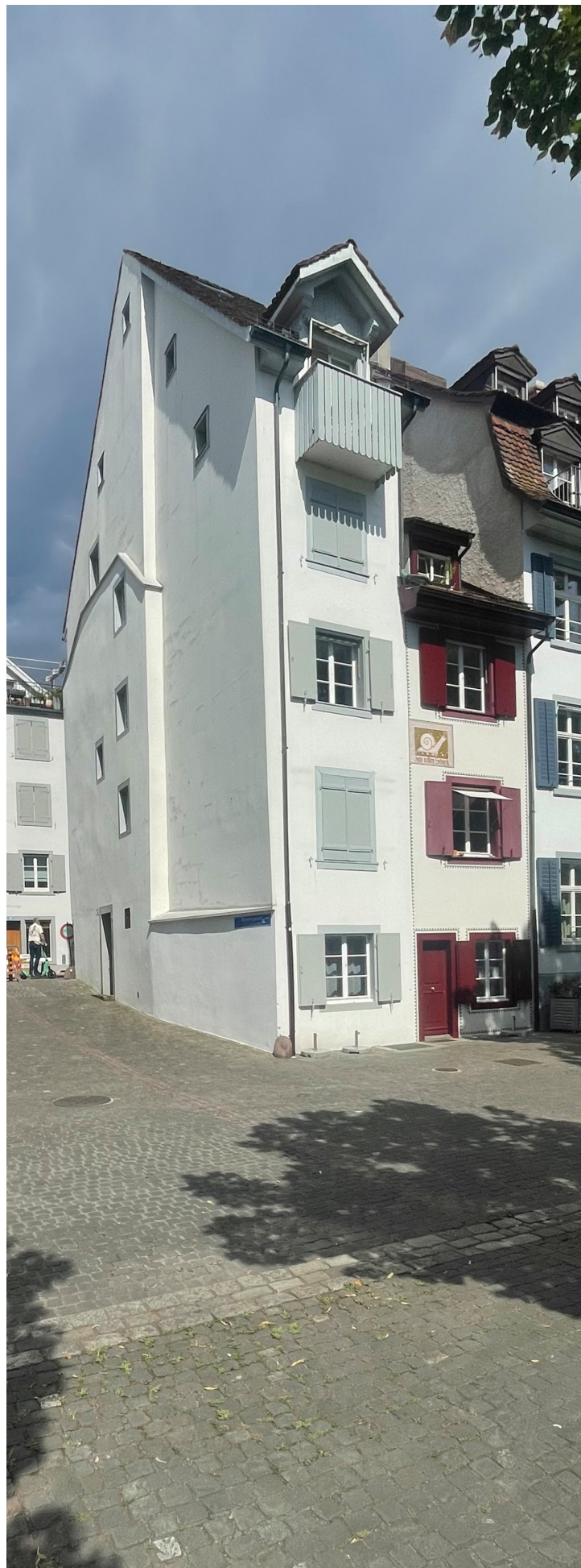
Ein Beispiel für Häuser, bei denen die Verpflichtung zur Einführung von Solartechnik geklärt werden muss und die Unterstützung benötigen, um die beste Lösung zu finden, sowohl technisch als auch ästhetisch und mit Rücksicht auf den historischen Charakter.
