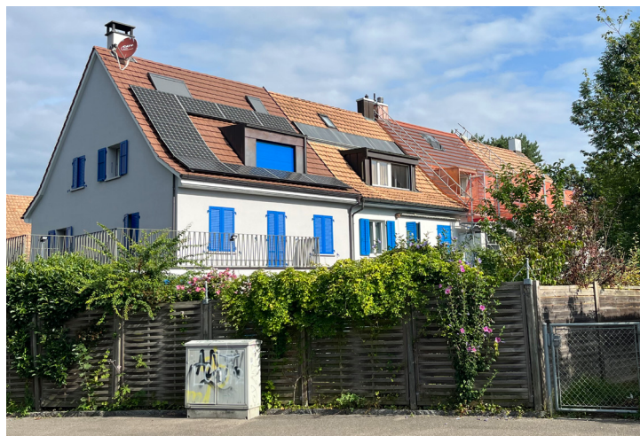
Beispiel für eine Reihe von vier Häusern mit "einem gemeinsamen Dach". Das erste auf der linken Seite wurde mit einer Patchwork-Lösung auf den Ziegeln aufgerüstet. Das dritte Haus von links hat ein neues, integriertes Solardach aus Ziegeln. Ein solches Dach sollte auf alle vier Häuser ausgedehnt werden, um die Architektur zu schützen und die Konsistenz innerhalb der historischen Bausubstanz zu gewährleisten. (Foto: Rolf Furrer)
