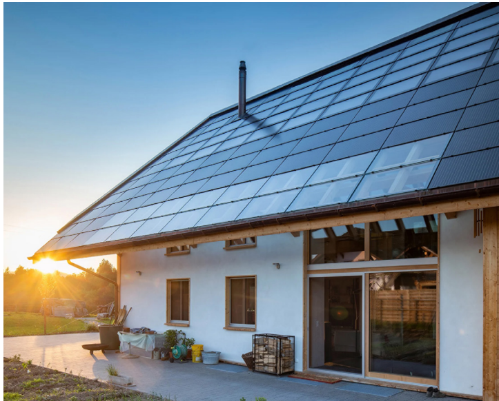
Ein vollständig integriertes Dachprojekt mit PV, Warmwasserkollektoren und Fenstermodulen von 3S. Quelle: https://www.3s-solar.swiss/3s-solardach#thermiepanel
