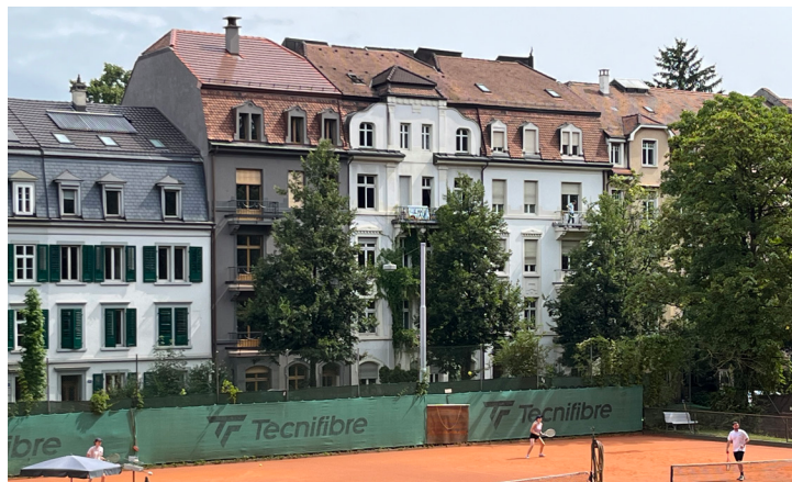
Gut ausgeführte Renovierung des Daches mit neuen Solarziegeln. Solche Lösungen sollten auf benachbarte Häuser ausgedehnt werden, um einheitliche, gut durchdachte Renovierungen zu fördern. (Foto: Rolf Furrer)
